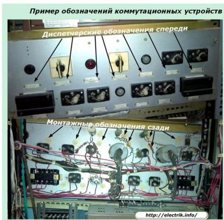
С обратной стороны панели против каждого элемента размещается наклейка (обычно круглой формы) с указанием дробью монтажной позиции согласно схемы вверху и краткого обозначения по схеме монтажа внизу, например, 019/HL3 — для лампы сигнализации.
